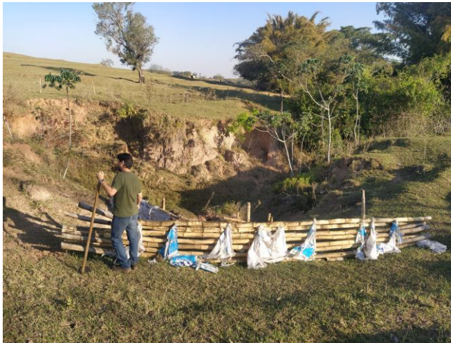
Figura 4. Técnicas de contención de la erosión en el APA del Timburi
