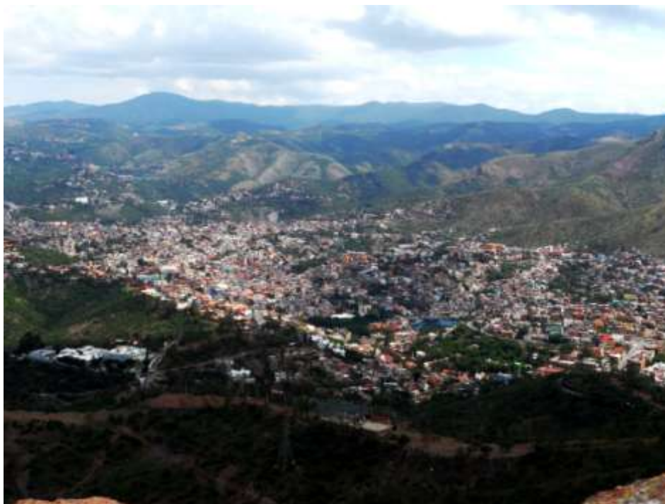
Fotografía 1. Perspectiva del emplazamiento de Guanajuato desde el llamado Cerro de la Bufa.
